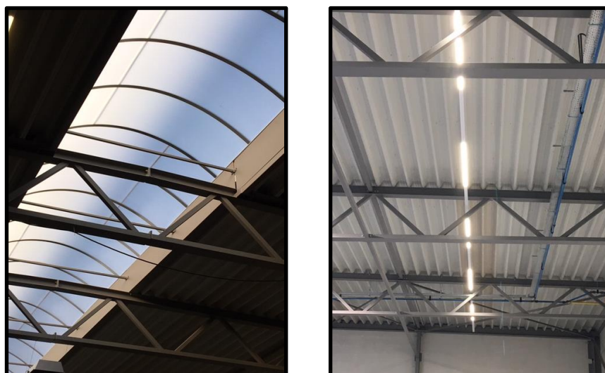
Figuur 8: Lichtkoepels & LED-verlichting
