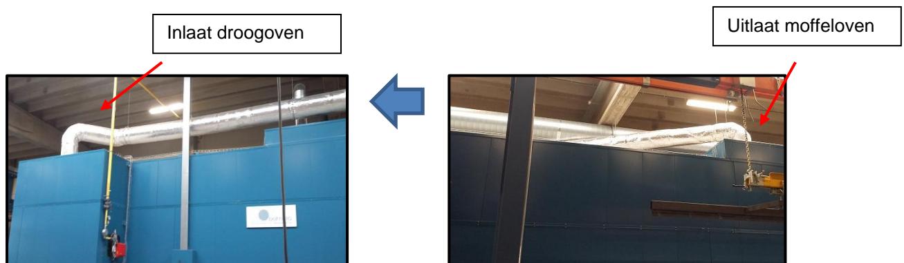
Figuur 4: Droog- en moffeloven (warmterecuperatie)
