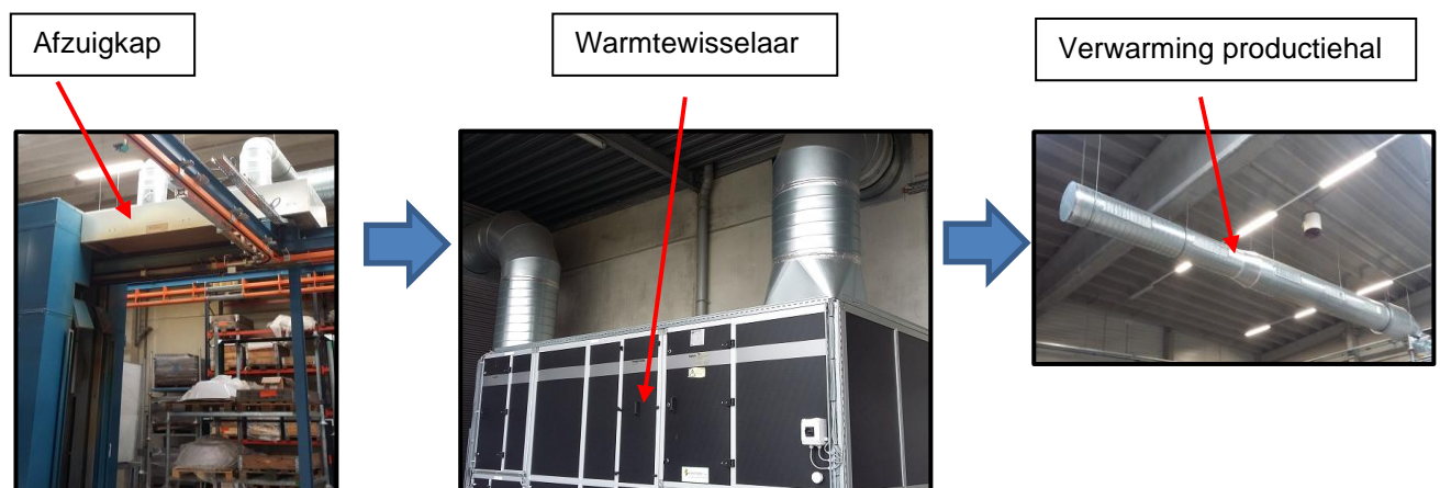
Figuur 5: Afzuiging ovens lakkerij (warmterecuperatie, verwarming productiehal)
