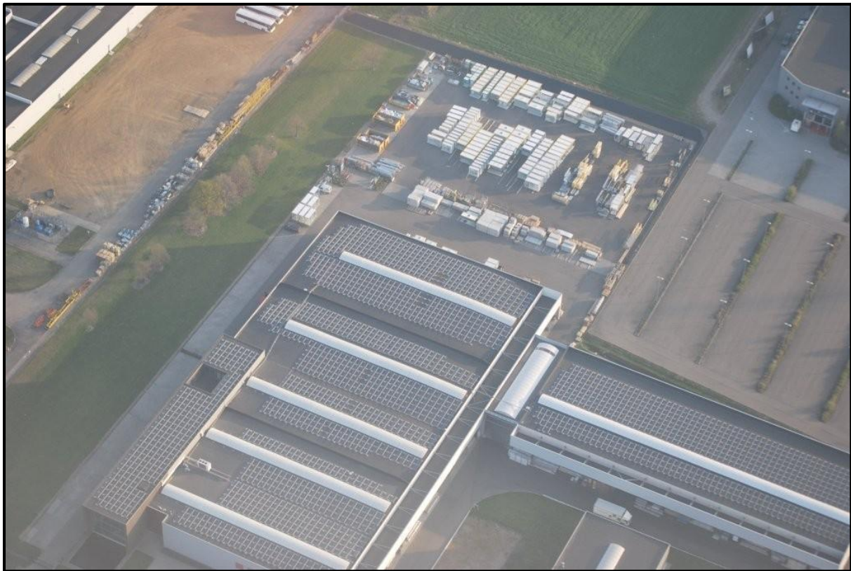
Figuur 5: zonnepanelen op het dak van EPSiLON te Bree
