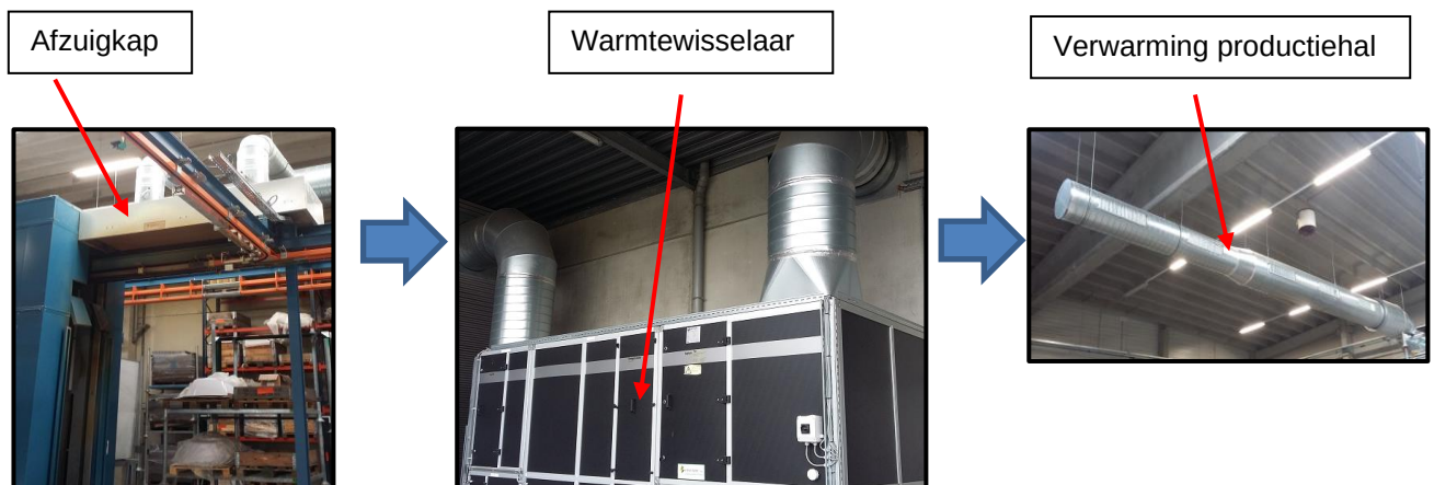
Figuur 5: Afzuiging ovens lakkerij (warmterecuperatie, verwarming productiehal)
