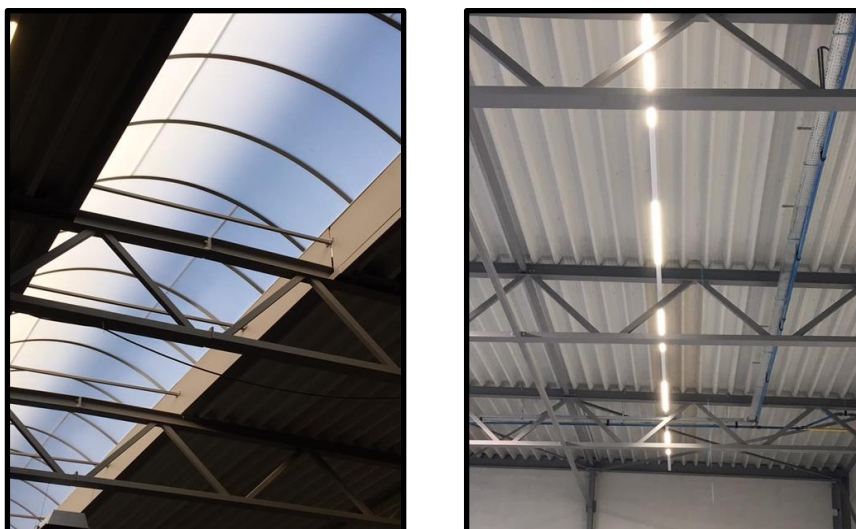
Figuur 8: Lichtkoepels & LED-verlichting
