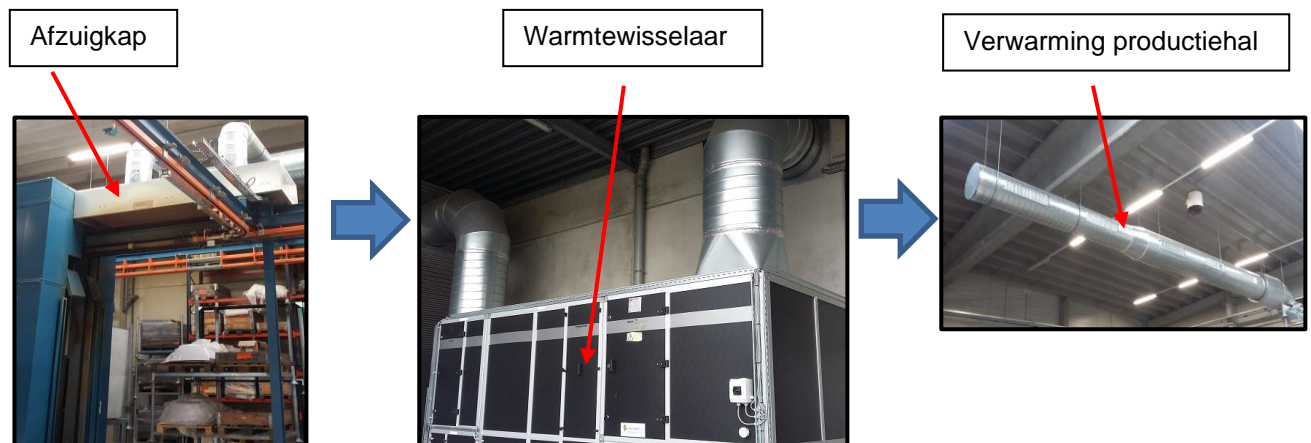
Figuur 5: Afzuiging ovens lakkerij (warmterecuperatie, verwarming productiehal)
